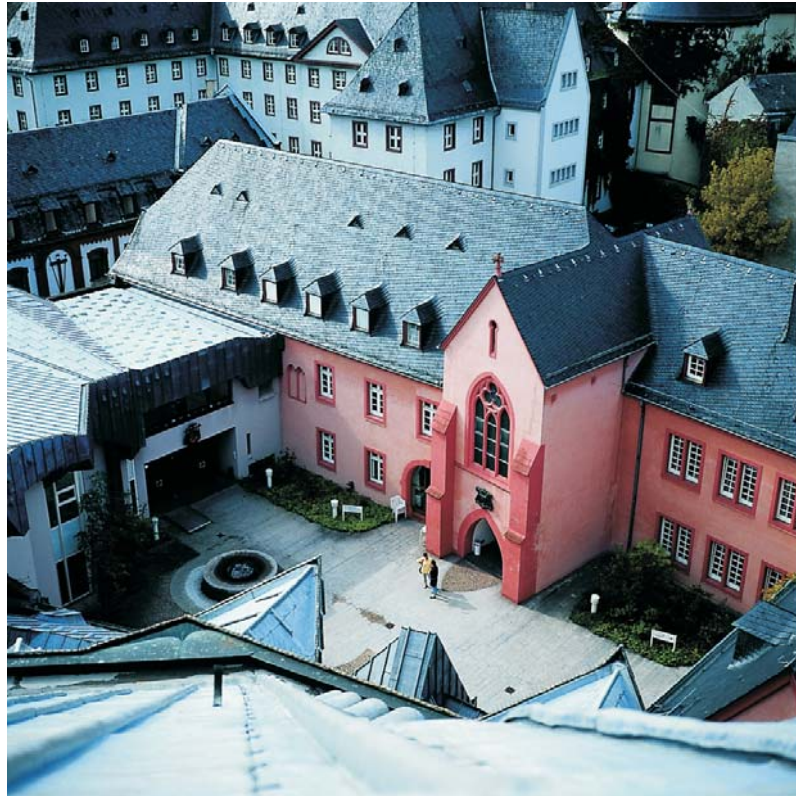
Der historische Innenhof im Erbacher Hof
